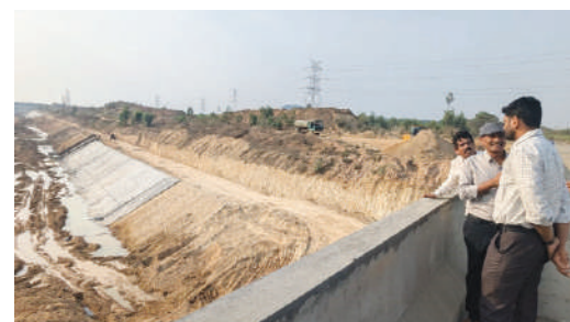
చేయాలని అధికారులు ఆదేశించారు. సీతారామ ప్రాజెక్టు కాలువ నిర్మాణ పనుల్లో నాణ్యత
